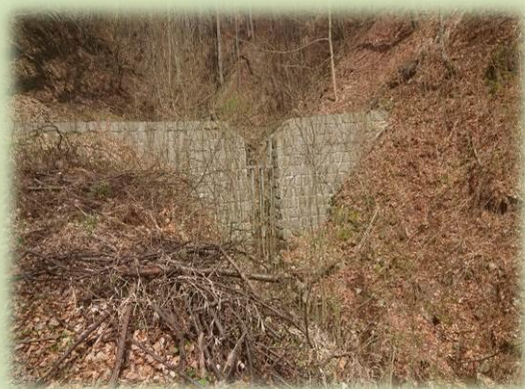
Obr. 3.6 Na fotografii vlevo je zdokumentována zděná retenční přehrážka na Vysutém potoce v ř. km 2,000. Na fotografii vpravo je kamenná konsolidační přehrážka na Hučivé Desné, která plní funkci stabilizace nivelety dna a zpomalení chodu dnových splavenin (ř. km 5,128).
