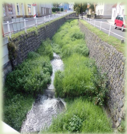
Obr. 4.3 Koryto Homolského potoka v intravilánu Velkého Března je téměř v celém profilu dna zaneseno plaveninami.
