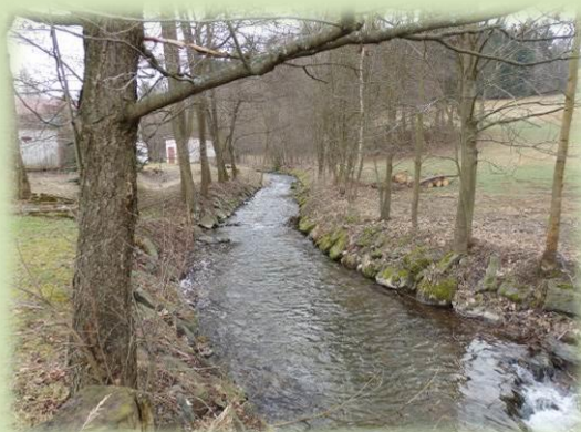
Obr. 3.7 Na fotografii vlevo je v korytě vodního toku Hluky v ř. km 0,300 – 0,700 opevněn břeh kamennou rovnatinou. Na fotografii vpravo je zobrazena dlážděná kyneta na Vysutém potoce ř. km 1,600 (stabilizace koryta a zamezení boční a hloubkové eroze, která však může urychlit transport sedimentů v rámci úseku z hlediska její nízké drsnosti).
