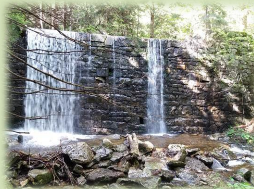
Obr. 3.6 Na fotografii vlevo je zdokumentována zděná retenční přehrážka na Vysutém potoce v ř. km 2,000. Na fotografii vpravo je kamenná konsolidační přehrážka na Hučivé Desné, která plní funkci stabilizace nivelety dna a zpomalení chodu dnových splavenin (ř. km 5,128).
