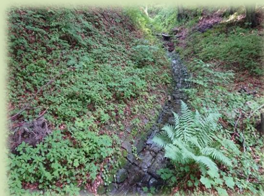
Obr. 3.7 Na fotografii vlevo je v korytě vodního toku Hluky v ř. km 0,300 – 0,700 opevněn břeh kamennou rovnatinou. Na fotografii vpravo je zobrazena dlážděná kyneta na Vysutém potoce ř. km 1,600 (stabilizace koryta a zamezení boční a hloubkové eroze, která však může urychlit transport sedimentů v rámci úseku z hlediska její nízké drsnosti).
