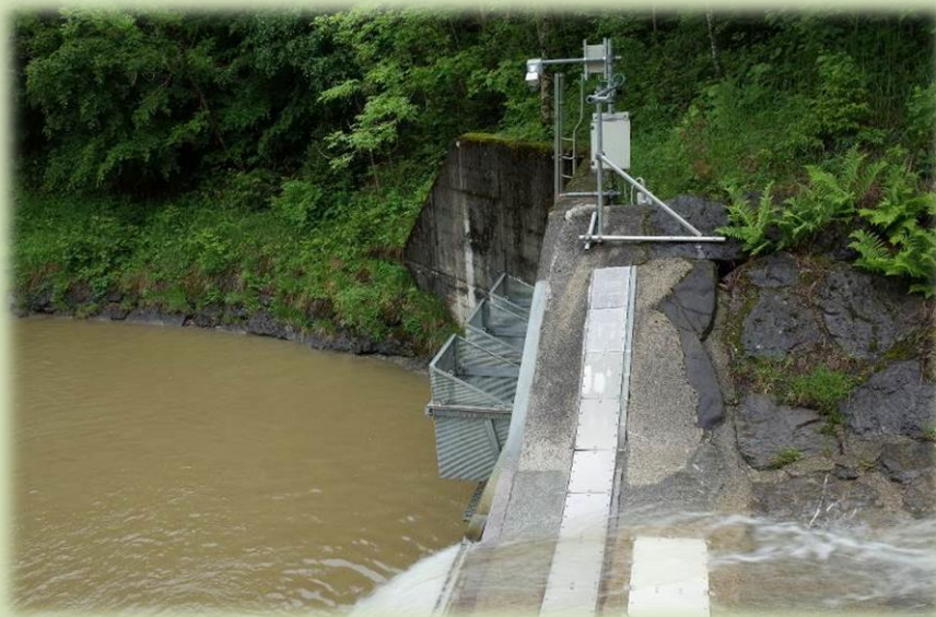
Obr. 4.1 Geofony na hraně spádového stupně kombinované se sběrem splavenin do vozíků (Erlenbach, Švýcarsko).
